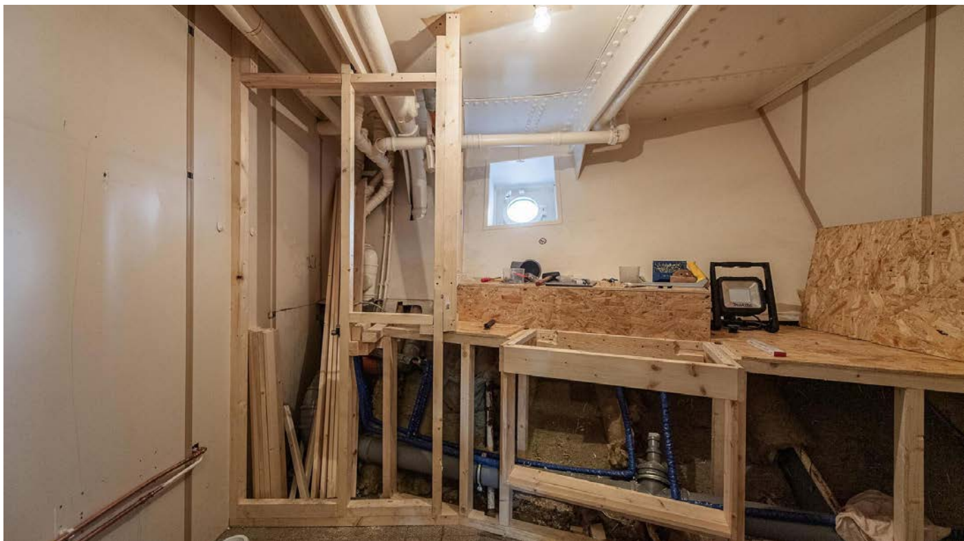
Hier entsteht ein neues Bad. Foto: Polgesek
